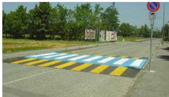
Attraversamento pedonale rialzato non conforme a legge
