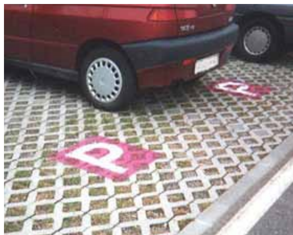
Segnaletica orizzontale non conforme a legge
