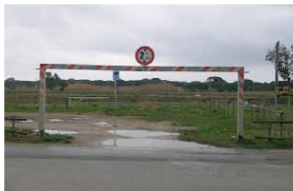
Esempi di impiego non corretto di sbarra ad altezza ridotta dalla sede stradale con divieto di transito per altezza
